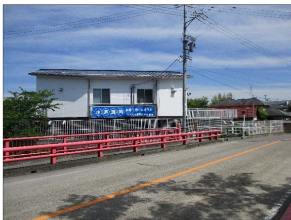
【大口南部配水場】
