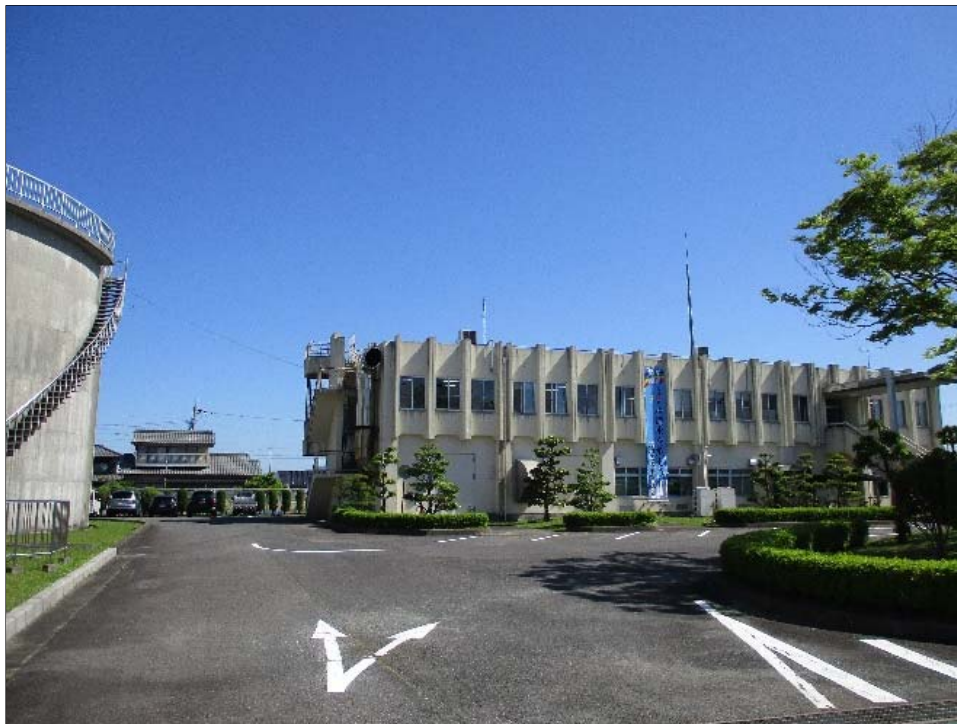
【河北配水場及び水道部庁舎】
