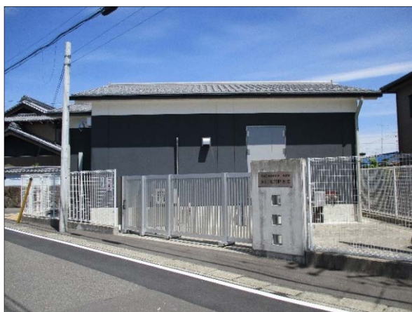
【大口北部配水場】
