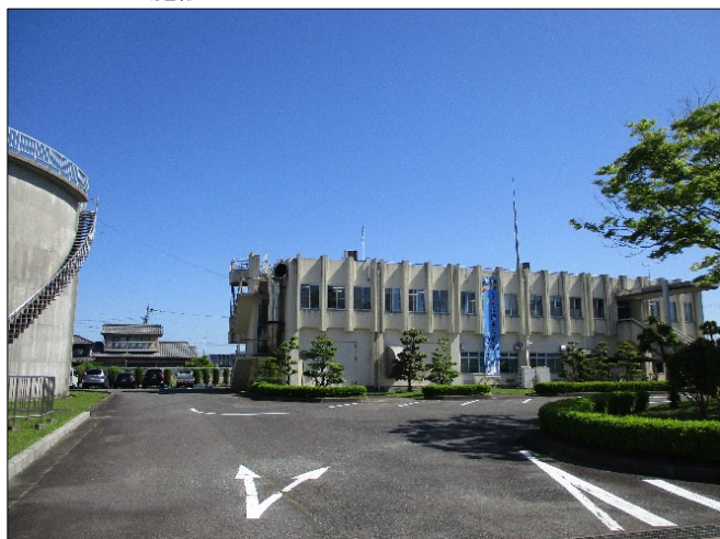
【河北配水場及び水道部庁舎】
