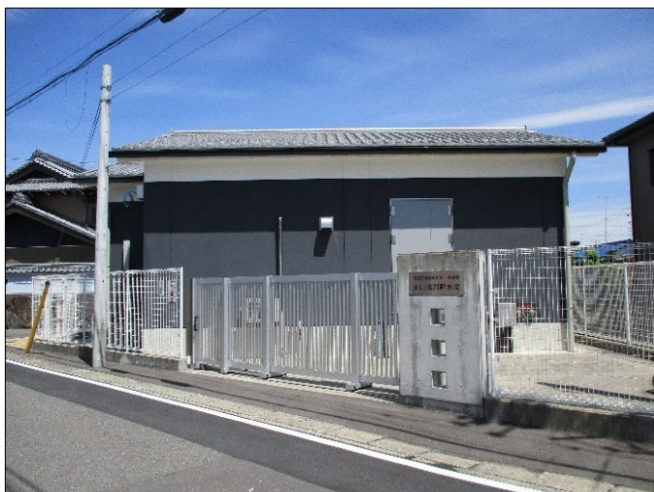
【大口北部配水場】
