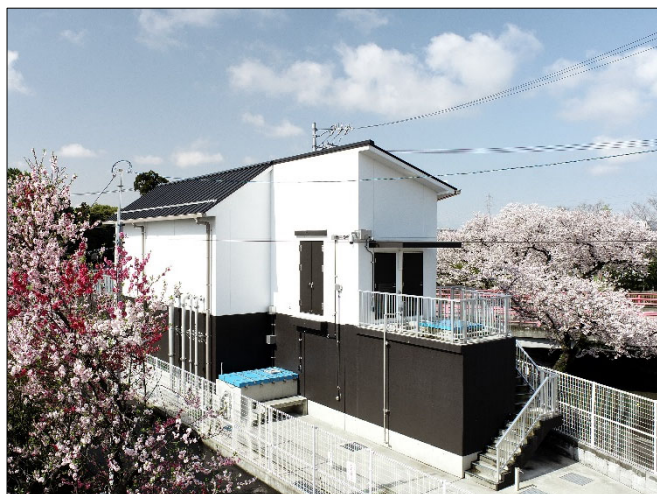
【大口南部配水場】
