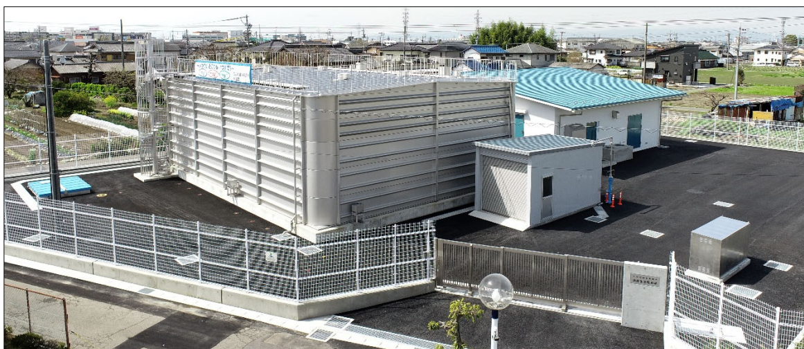
【扶桑北部配水場】
