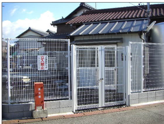
【北定松配水場】
