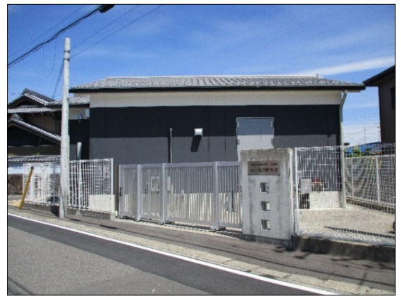
【大口北部配水場】
