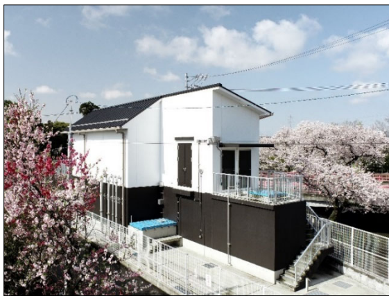
【大口南部配水場】
