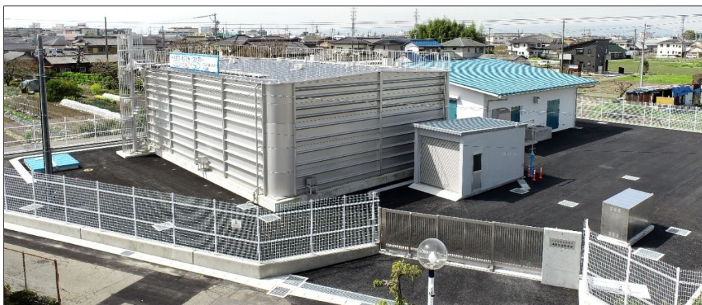
【扶桑北部配水場】
