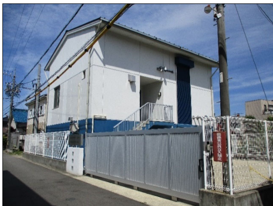
【柏森北部配水場】
