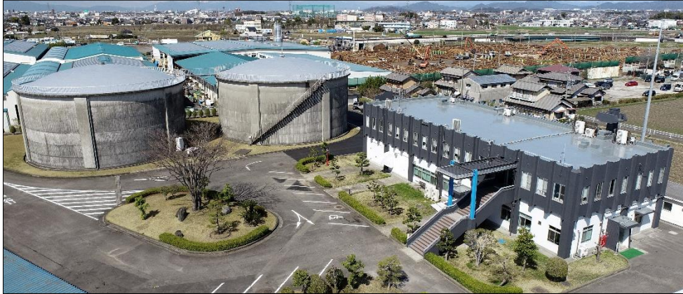
【河北配水場及び水道部庁舎】
