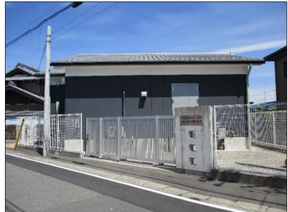
【大口北部配水場】
