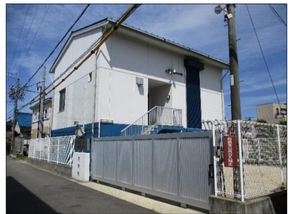
【柏森北部配水場】
