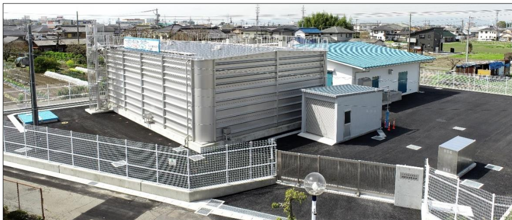
【扶桑北部配水場】
