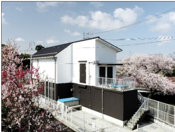
【大口南部配水場】
