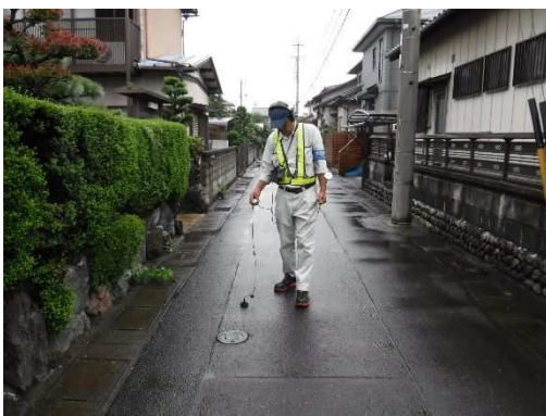
漏水調査の様子
