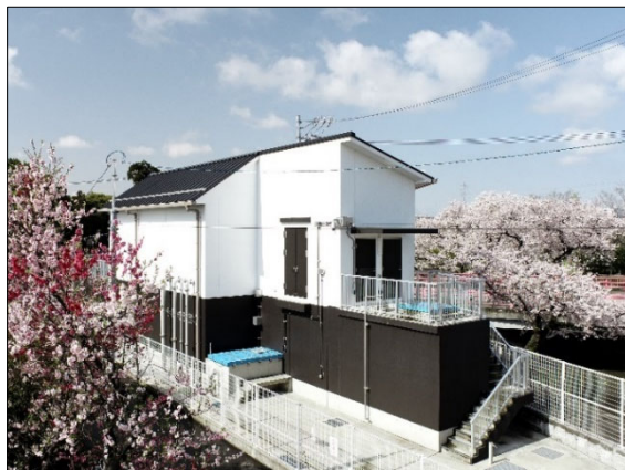
【大口南部配水場】
