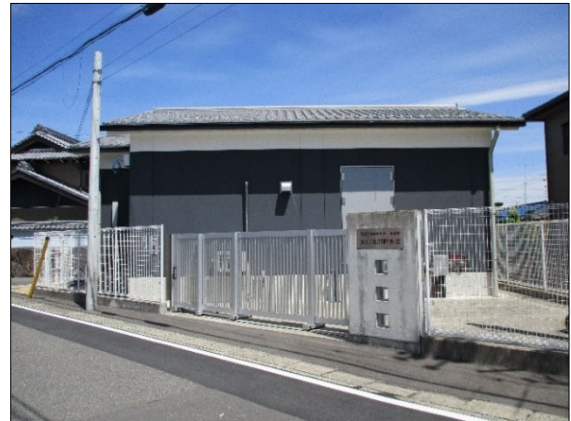
【大口北部配水場】
