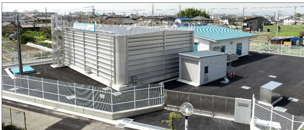
【扶桑北部配水場】
