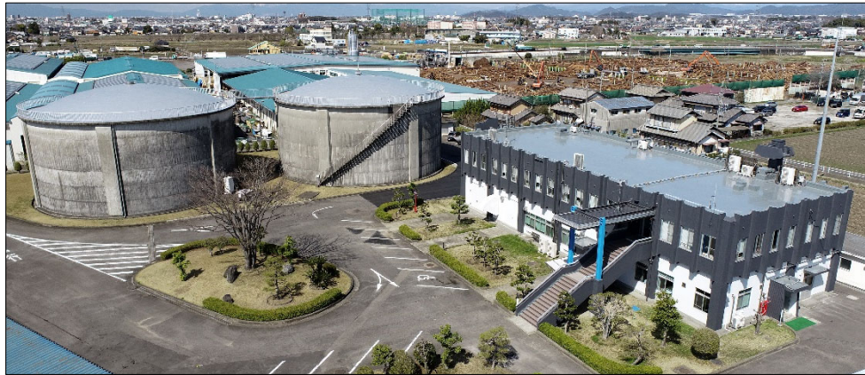
【河北配水場及び水道部庁舎】
