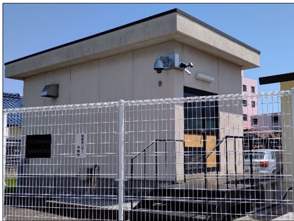
【柏森南部配水場】
