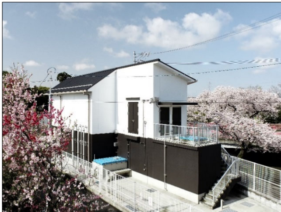
【大口南部配水場】
