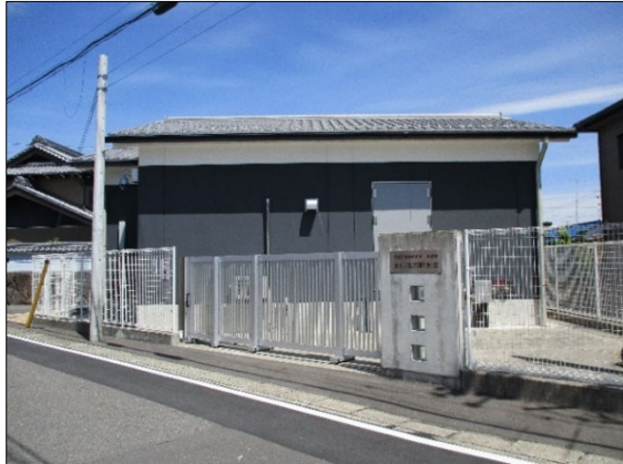
【大口北部配水場】
