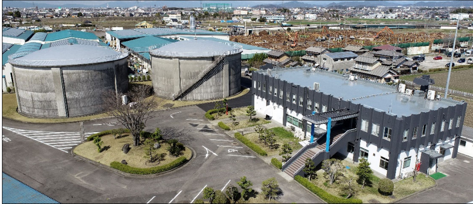
【河北配水場及び水道部庁舎】
