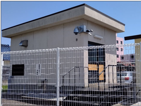
【柏森南部配水場】
